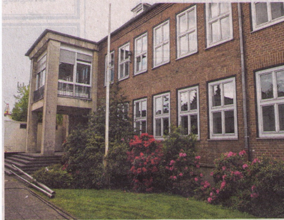
Das Berufskolleg in Geldern wird in den kommenden Jahren kernsaniert.
