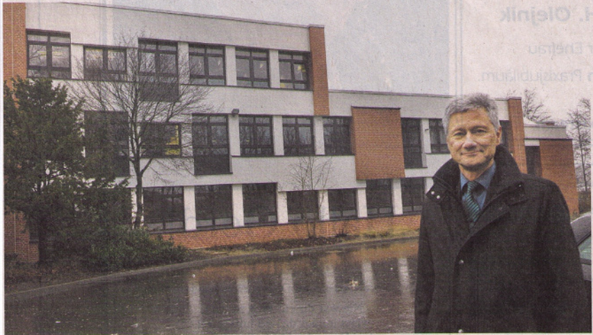
Landrat Wolfgang Spreen vor dem Berufskolleg in Kleve: Hier sind die Sanierungsmaßnahmen so gut wie abgeschlossen, hat der Kreis inzwischen über 3 Millionen Euro investiert.
